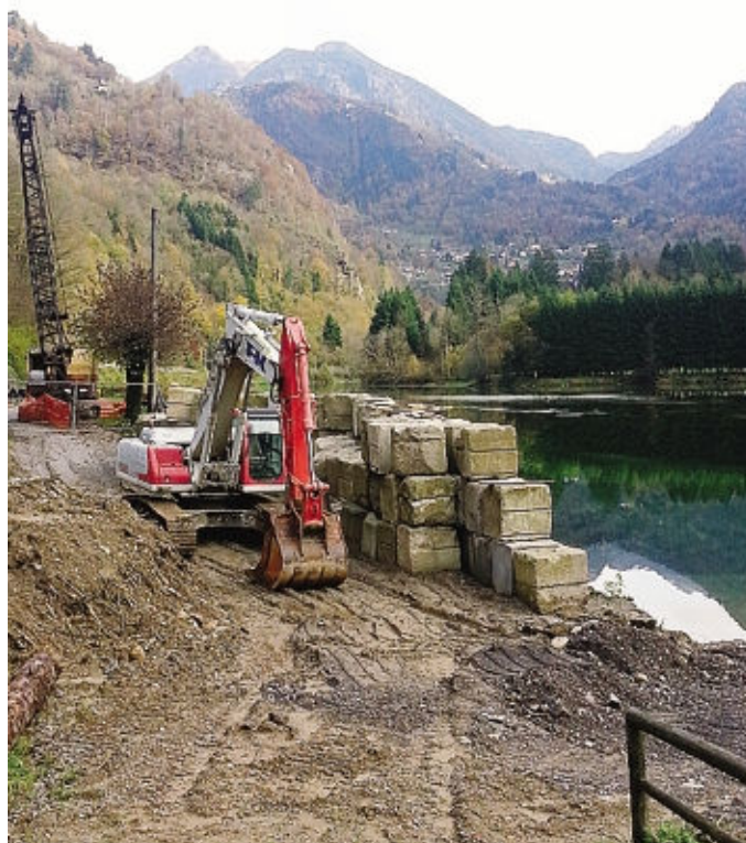
I lavori al lago del Bernigolo di Moio
