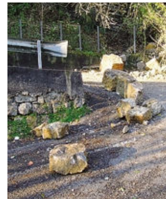
La frana caduta a Strozza
